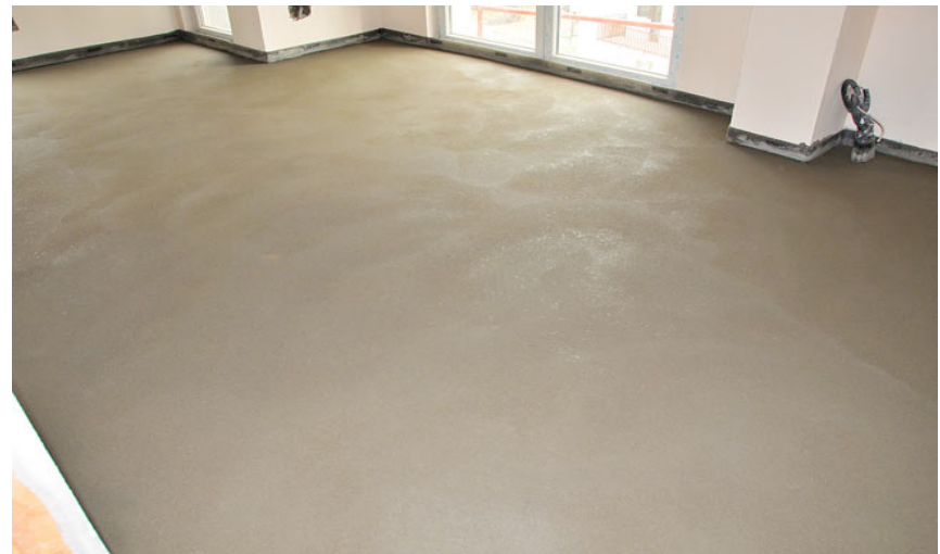
Podlahový potěr po aplikaci
